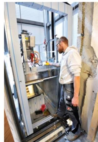
Aufzugsmonteur Philipp Weißbach von der Firma Lindner-Montage GmbH beim Einbau der neuen Aufzugsanlage.
