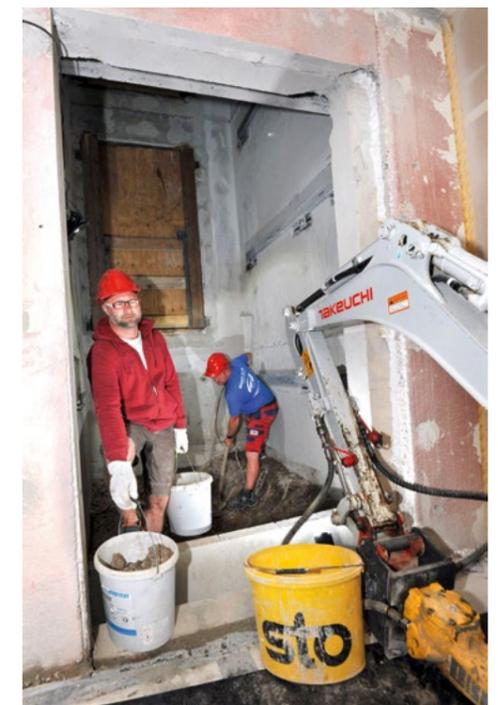
Jens Klemm und Ralf Mehner von der Firma IST Bau beim Aufbruch der alten Aufzugschachtgrube. 1,40 Meter purer Beton pro Aufzug müssen für die neuen ebenerdigen Aufzüge raus.
