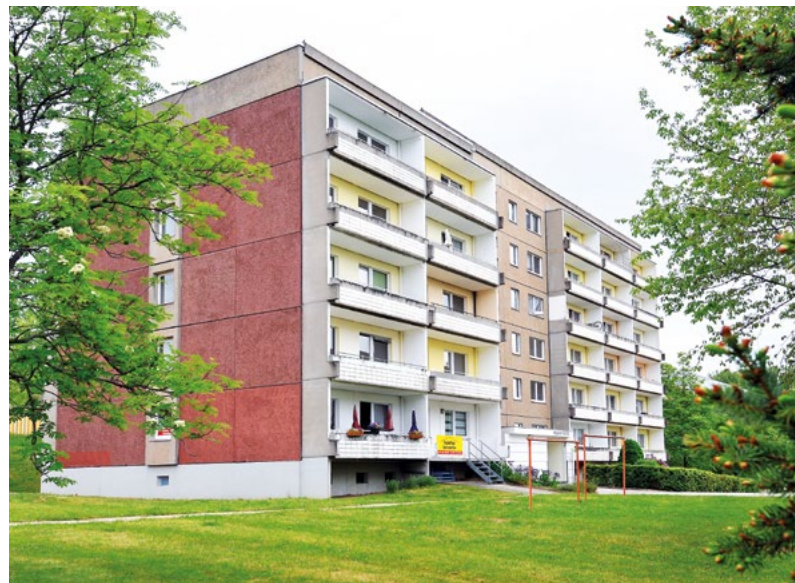
Das Wohnhaus Wolgograder Allee 204 in Hutholz wird saniert.
