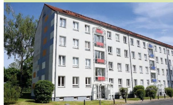
Sanierter Wohnblock an der Comeniusstraße
