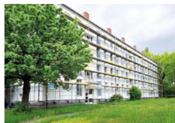
An der Gustav-Freytag-Straße 7 – 11 werden die Fassade erneuert und Balkone angebaut.
