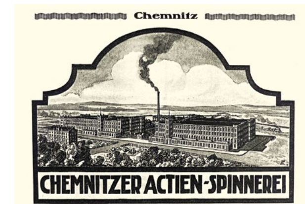
Ansicht der ab 1896 errichteten Aktenspinnerei in Altchemnitz
