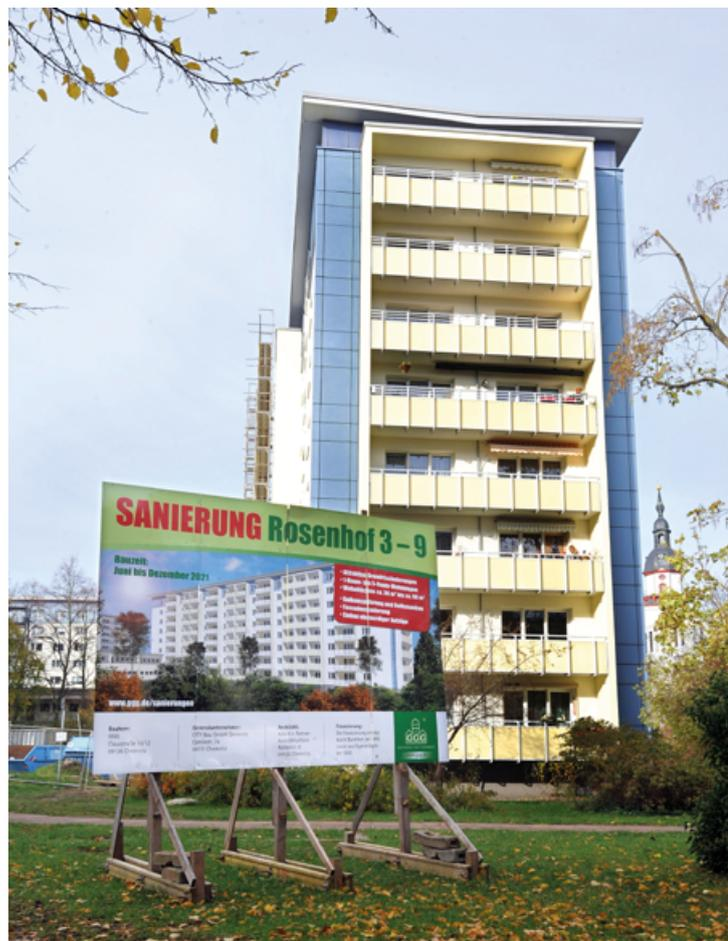
Das Wohnhaus Rosenhof 3 – 9 wird derzeit saniert. Balkone werden angebaut, die Fassade neu gestaltet, Aufzüge erneuert und Rampen an den Hauseingängen errichtet.
